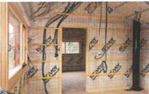
L'isolation se place entre les éléments de structure bois. L'étanchéité à l'air se réalise à la fois par la pose d'une membrane dont sa parfaite mise
