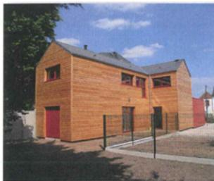
L'utilisation du Bois a été privilégiée, un isolant extérieur en fibre de bois a été utilisé pour le traitement des murs mais également en sous-toiture permettant de donner de l'inertie au bâtiment. Un bardage en clins de mélèze non traité permet l'étanchéité des murs. Le choix des menuiseries s'est porté sur du mixte aluminium bois.
